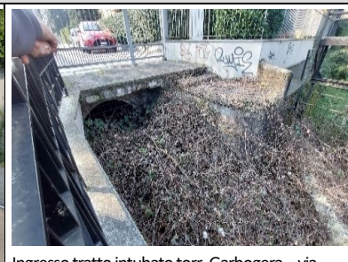
Ingresso tratto intubato torr. Garbogera – via Manzoni
