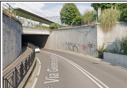
Sottopasso ferroviario – via Di Vittorio -fonte Google
