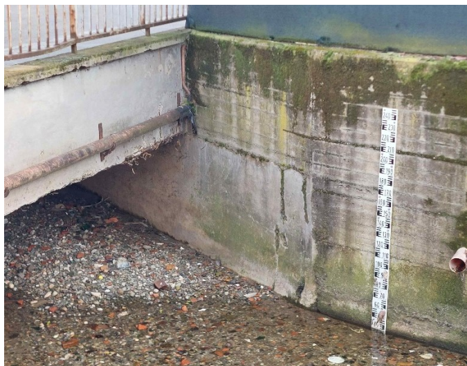
Foto – Asta idrometrica lungo il torrente Pudiga al confine tra Novate M. e Baranzate. Dx livelli registrati durante la piena del 22 settembre 2025 – fonte NOC Novate M.
